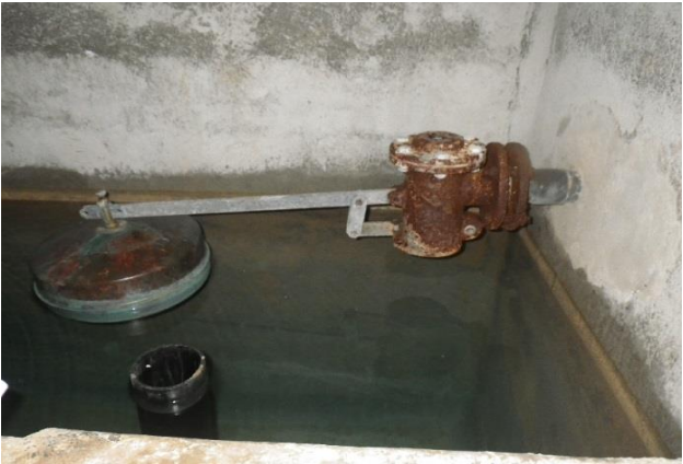
Robinet flotteur -arrivée du captage de Bouraille et trop
