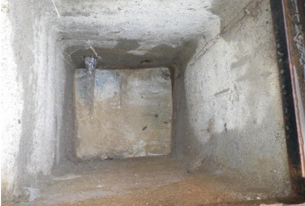
Regard d'évacuation du trop plein en PE 63 mm
